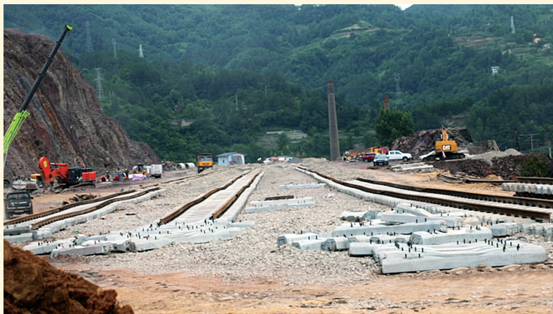
建设中的位于万源市青花镇的储配煤基地
