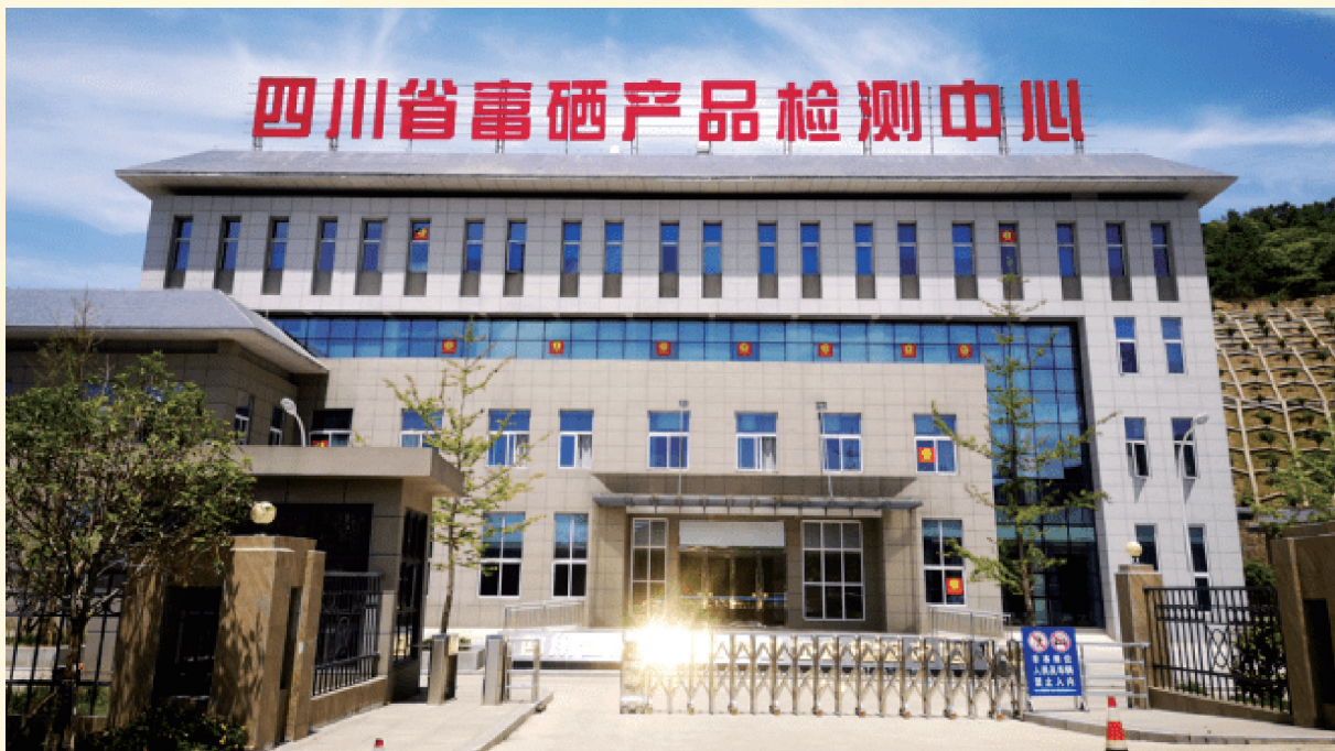
位于万源市太平镇的四川省富硒产品检测中心
