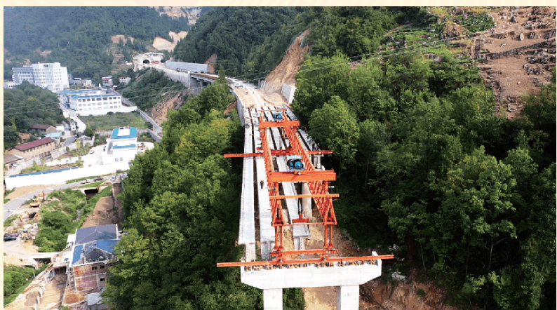
建设中的万八快速通道建设项目李家沟二号桥
