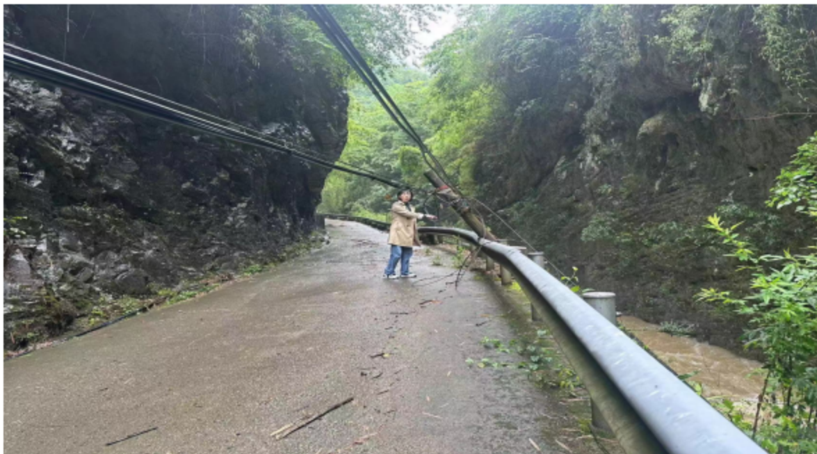
实地查看道路、线路等基础设施损坏情况
