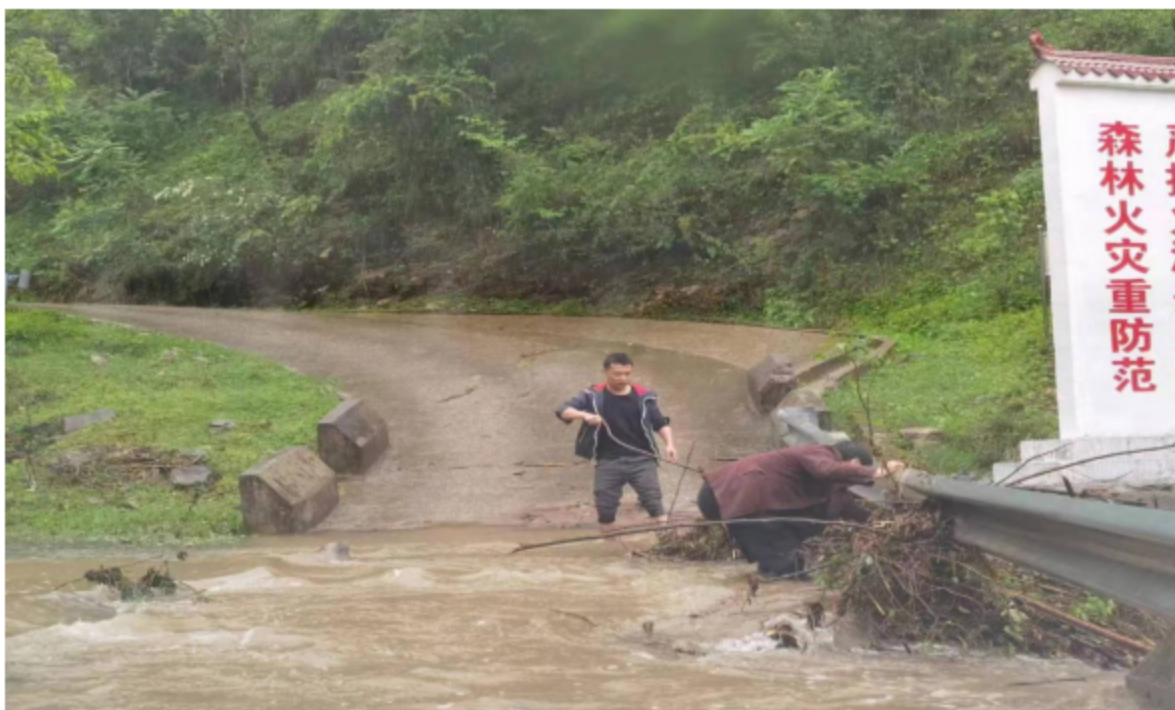
开展河（沟）道大疏通行动
