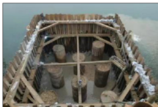
图2-33 围堰施工示意图
