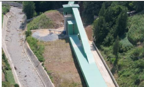
皮带廊道及除土筛封闭情况
