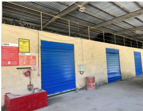
依托危险废物暂存间
