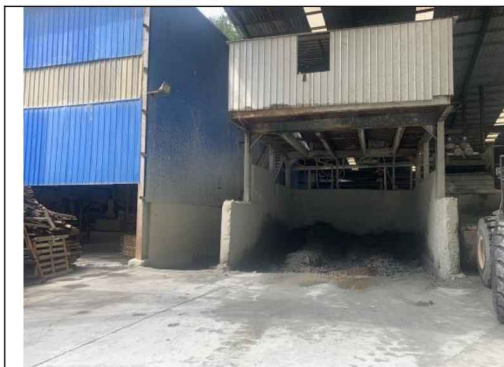
图 1：车间内干化泥饼暂存池
