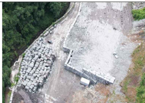
图 2：车间南面固废堆场
