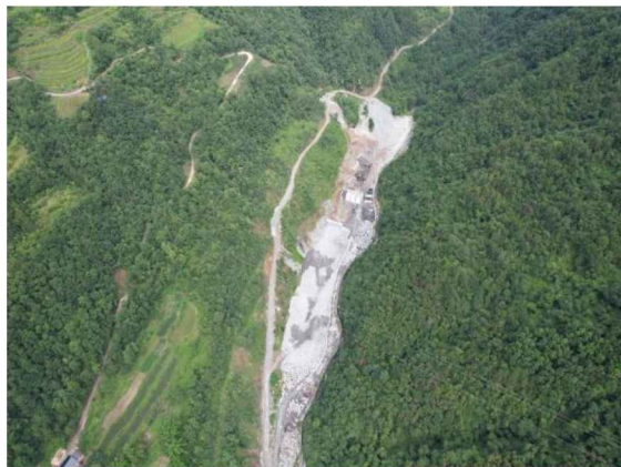
照片 2：项目厂区原固废堆放区（拟建固废加工车间）
