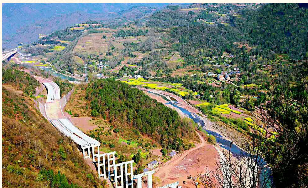
巴通万高速公路黄钟段（黄钟镇提供）
