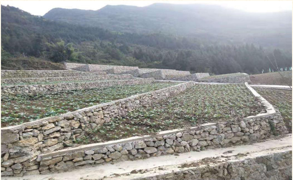
旧院镇土地整理项目整治坡改梯（市自然资源局提供）
