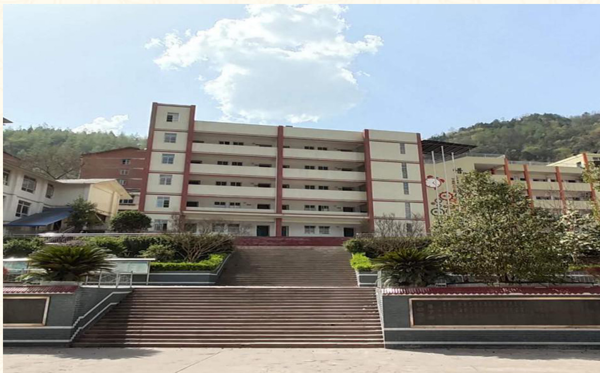
黄钟镇中心小学校教学综合楼（黄钟镇提供）
