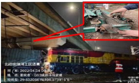
2022年4月3日，重庆沙坪坝区境内，某市政设施维管公司对上跨兴路线的公跨铁桥梁安全栅栏维护不到位，发生安全栅栏掉落侵入铁路建筑限界，导致铁路接触网承力索断线，影响货车36列，构成铁路交通一般事故。对地方政府有关部门及铁路单位定责、约谈，对涉事公司行政处罚。
