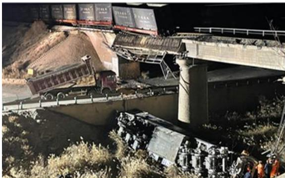
2022年3月8日，甘肃省白银市境内，一辆重型自卸货车在运行中升起的车厢碰撞红会线K60+807处铁路桥梁，造成该桥梁体翻转倾斜，线路变形，致通过的DF8B型货物列车牵引机车及机次第一位车辆脱轨坠落，造成司乘人员3人死亡、1人重伤，中断行车47小时38分，构成铁路交通较大事故。追究涉事公司及相关人员、属地政府相关部门责任。
