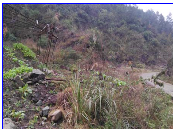
照片 4 项目区西面山坡
