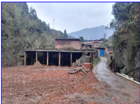
照片 1 项目区现状
