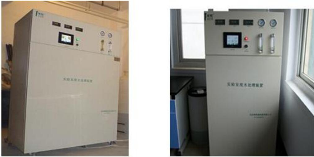
图 5-4 实验室废水处理装置图
