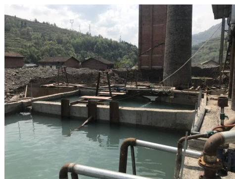
生产废水沉淀池
