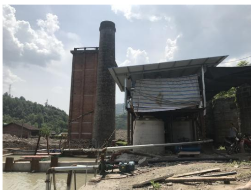
废水处理系统
