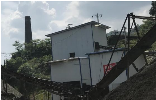
车间密闭情况
