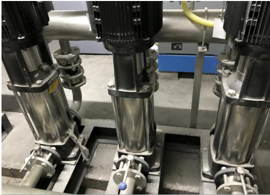
水泵采用胶垫和水泥垫层减震
