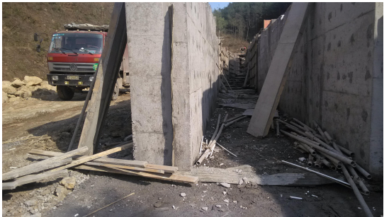
排水渠建设情况
