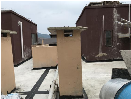
住户楼顶排烟道
