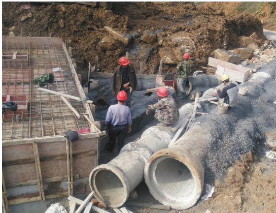
小区管网建设情况
