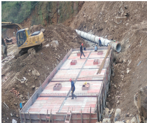
初沉池建设情况
