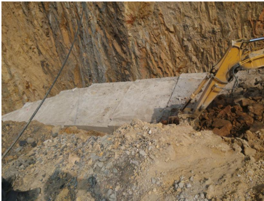
排水渠建设情况
