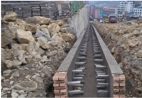
雨水管网建设情况
