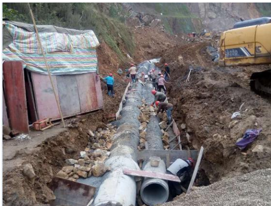
小区管网建设情况
