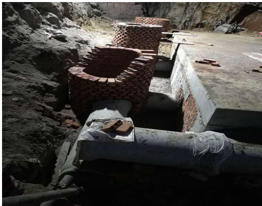
初沉池建设情况
