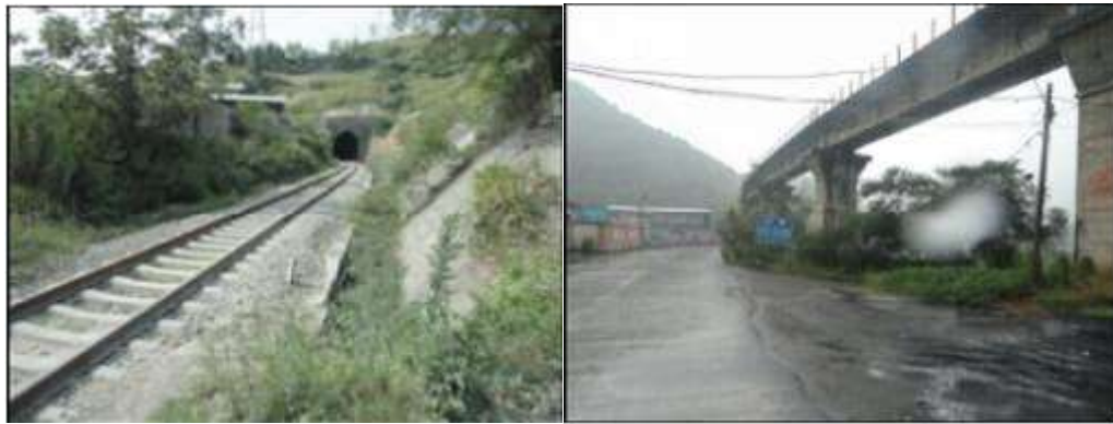
图 1-17 上跨万白铁路桥位处实景照片
