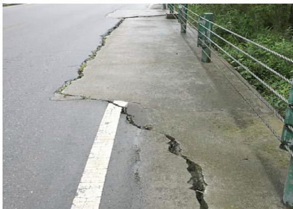
图 1-25 原路段路面破损情况
