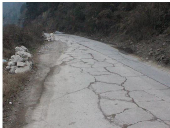
图 1-25 原路段路面破损情况
